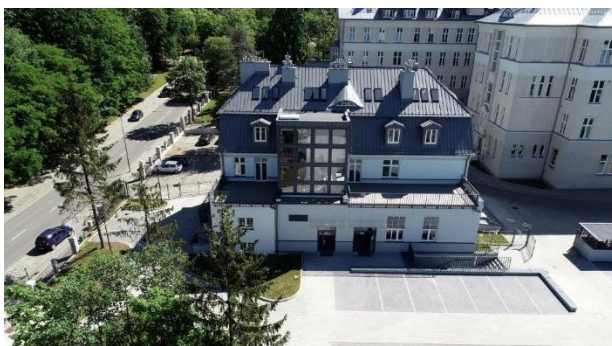
Budynek przy ul. Obrońców Wybrzeża 3 w Słupsku.
