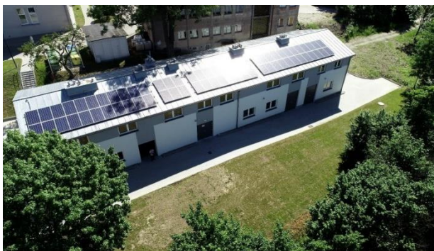
Budynek przy ul. Obrońców Wybrzeża 3B w Słupsku.
